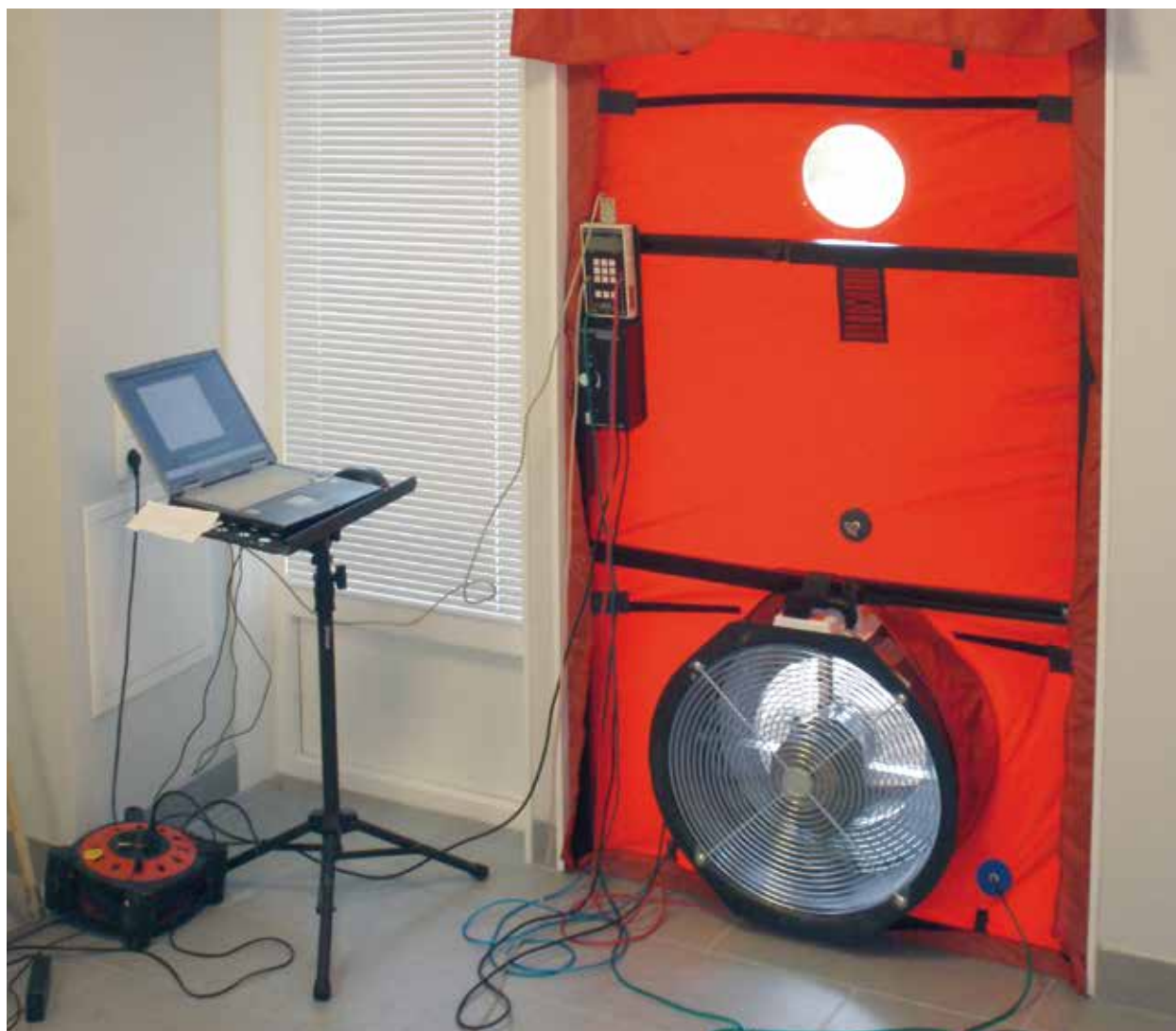
Attēls: Gaisa necaurlaidības mērījumi nosaka ēkas noplūdes vietas pirms konstrukcijas noslēgšanas.
