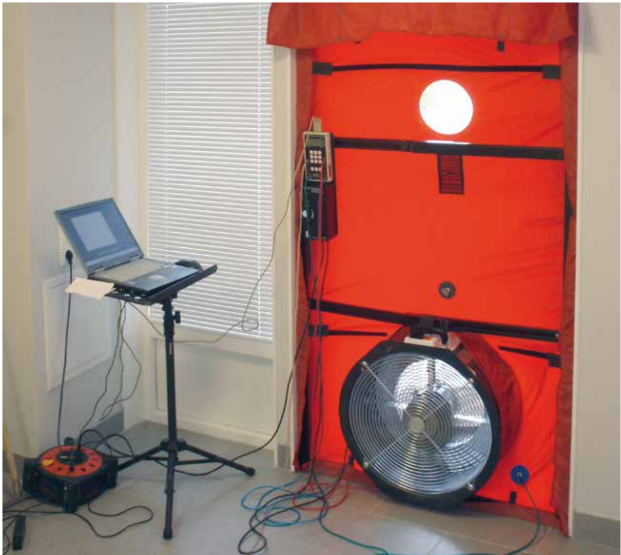
Sandarumo matavimas parodo nesandarias pastato vietas netgi prieš konstrukcijų sandarinimą.
