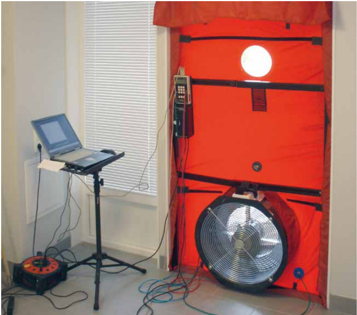
Ilmatiiviyysmittaus paljastaa rakennuksen vuotokohdat jo ennen rakenteiden sulkemista
