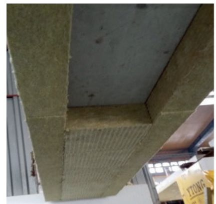
Betonipalkin alapinnan eriste kiinnitetään PAROC Jousiruuveilla (XFS 001).
