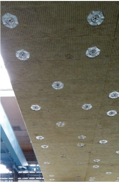
Palosuojattu betonilaatta.
