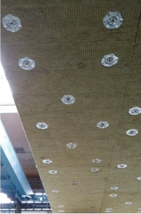
Palosuojattu betonilaatta.
