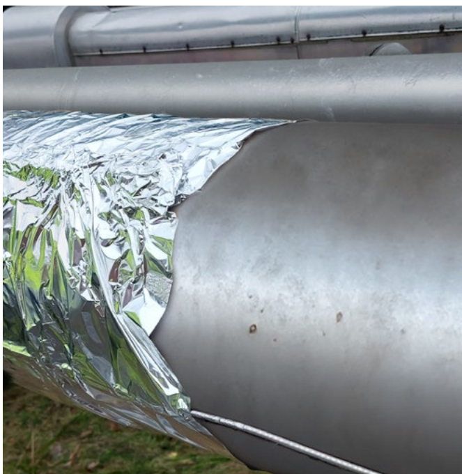
KONVENTIONELLE METHODE MIT SEPARATER ALUMINIUMFOLIE ↑
